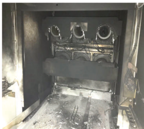
Fig. 2. Celda fallada en tablero de generación.
